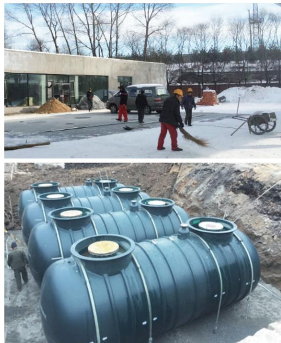
澳科中意3DFF®双层油罐技术来源于加拿大ZCL公司，加拿大很多地区的温度都比东北地区低，而3DFF®双层油罐在加拿大的市场占有率接近90%，因此，在高寒环境下3DFF®双层油罐完全不受影响，不会出现冻裂的情况。对于注水的问题，考虑到如果不注水，后期入油后，油罐可能会有沉降甚至可能会有管道撕裂、路面下陷等风险存在。同时，地下水位太高若再降雨的话，可能存在浮罐风险，因此施工过程是需要注水的。注水后，通过自然沉降，可以有效的预防下沉或者浮罐的风险。考虑到天气的原因，注水沉降后可以在48小时后将水抽出。澳科中意3DFF®双层油罐的测漏监测液是卤水，在配置的时候充分考虑天气寒冷的情况，不仅不会结冰、而且不会因为低温析出，在低温环境下具有较强的环境适应性。
